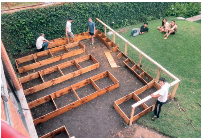
Panorama de los cajones instalados
