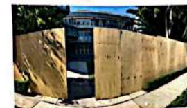
Parte de la cafetería cerrada por la falta de permisos del nuevo edificio.
